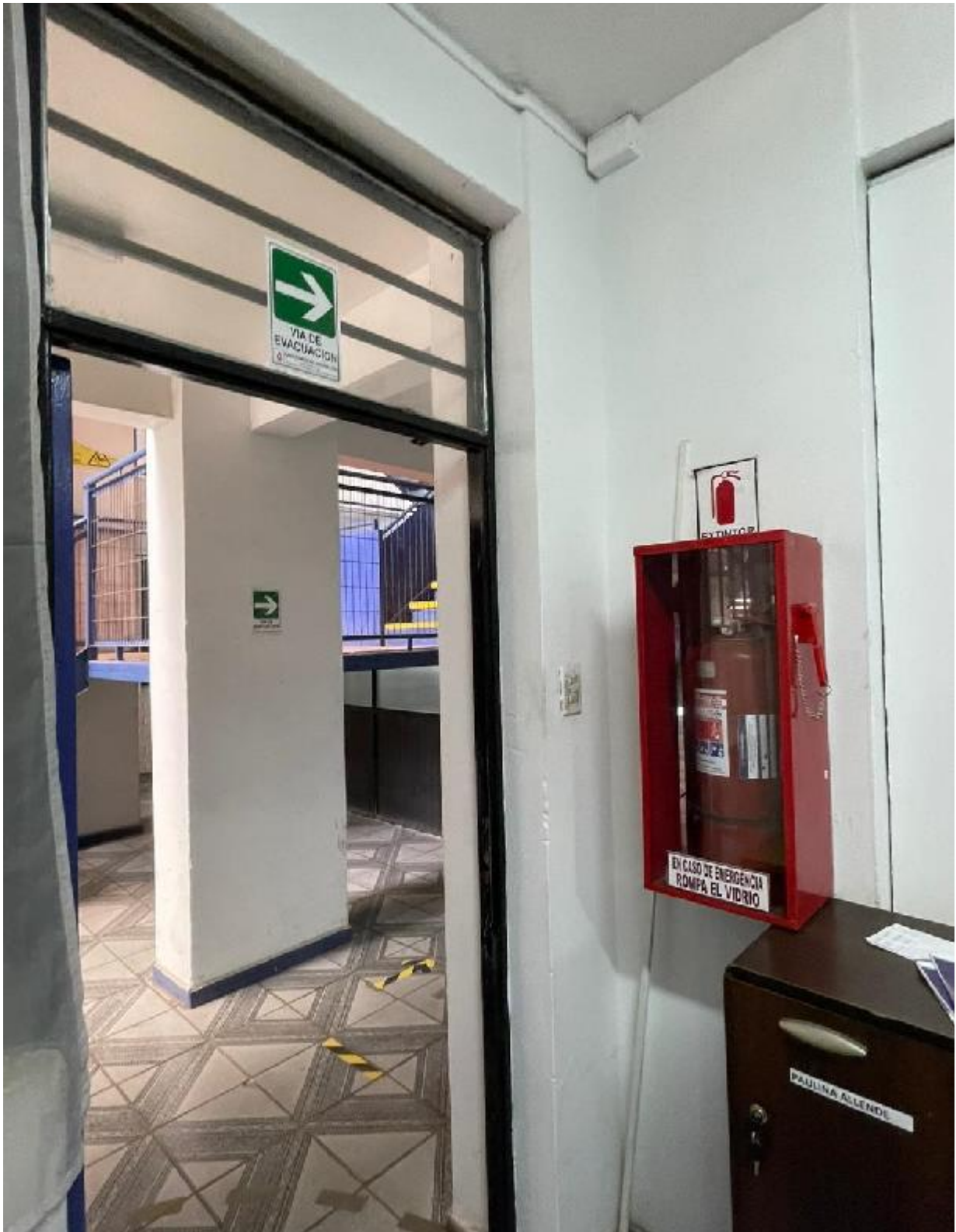
Vía de Evacuación Sala de Profesores
